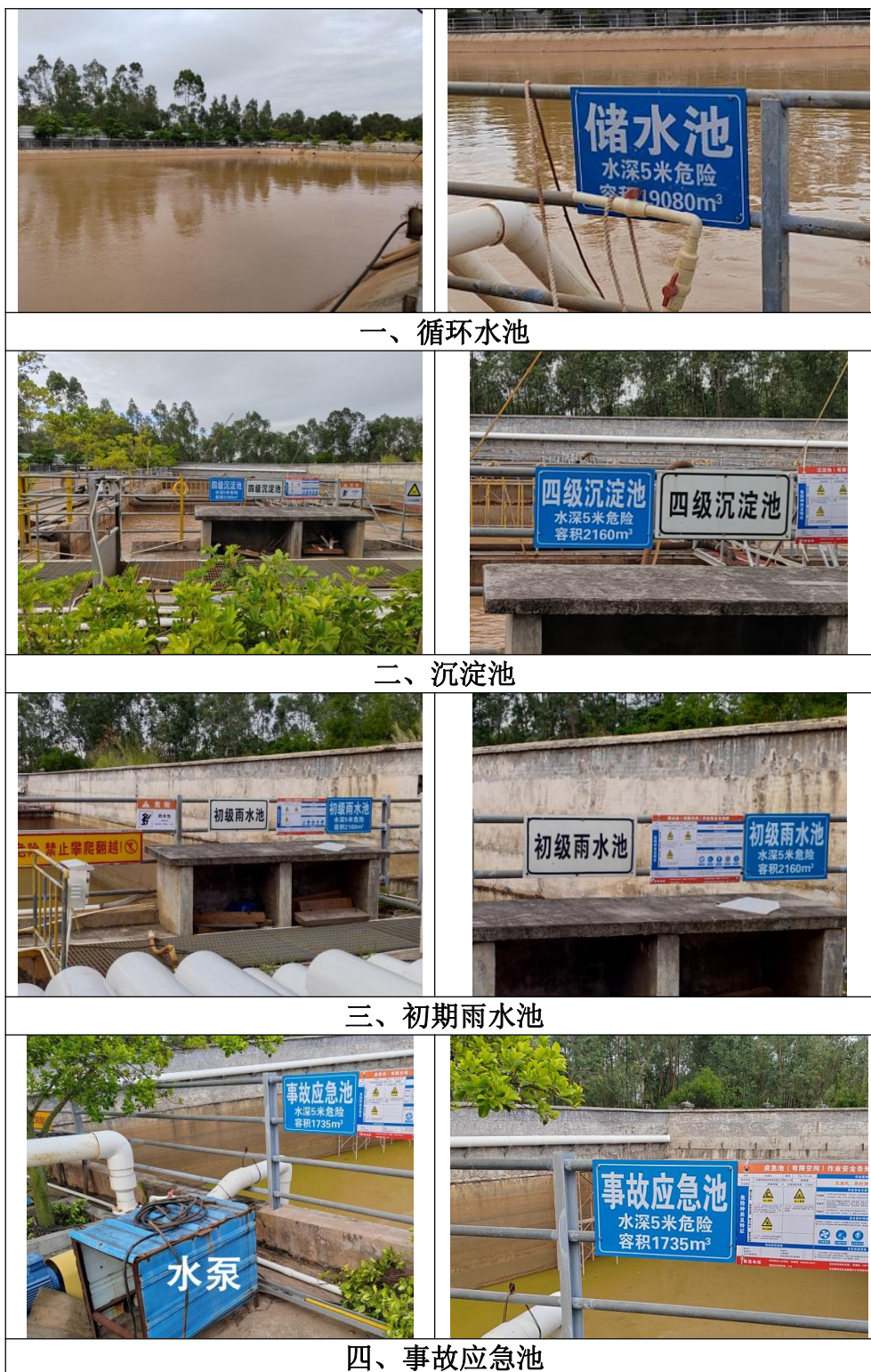
图 3.5-2 厂区各类池体现状照片
