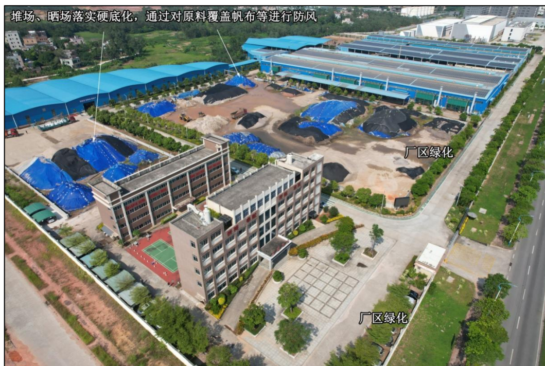
图 4.2-3 厂区现状地面硬底化和绿化照片
