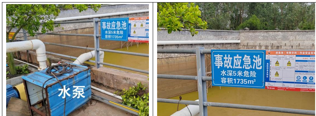
图 4.2-2 事故应急池现状照片
