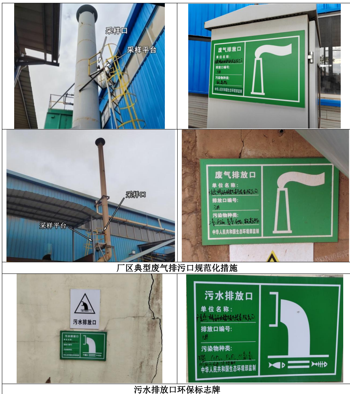
图 4.2-1 厂内典型的排污口规范化设置及现场照片
